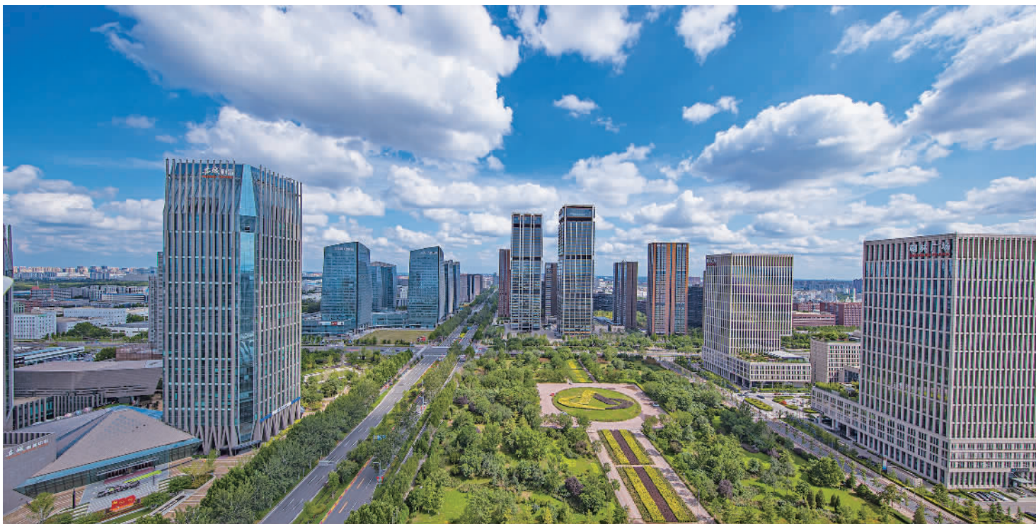
产业生态枝繁叶茂，城市形态更新发展，产城融合助推北京经济技术开发区实现高质量发展。
