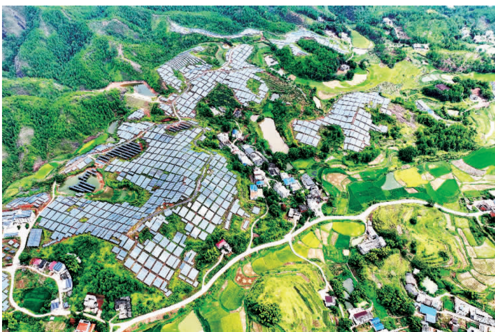
9月12日，晨光中的江西省赣州市会昌县庄口镇黄沙村光伏发电站。近年来，会昌县大力发展光伏产业，不仅给村集体带来了山地租金收入和产业分红，也为村民增加了光伏发电企业就业岗位，为偏远山区乡村振兴提供了源动力。 朱海鹏摄(中经视觉)
