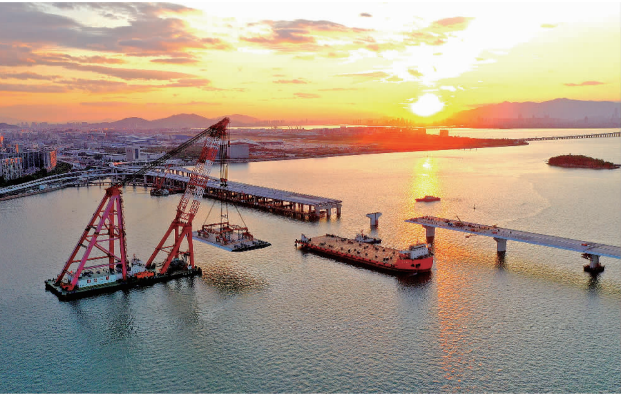
9月12日，继港珠澳大桥之后国内第二座、福建省首座全桥预制装配化跨海大桥——厦门第二东通道(翔安大桥)主桥成功合龙。翔安大桥全长约12公里，其中跨海桥梁(海中区)约4.5公里。大桥建成后，将进一步完善海西经济区路网，促进海峡两岸区域一体化发展，对厦门加快建设“一带一路”国家物流新通道具有重要意义。 何鸿鸣摄(中经视觉)
