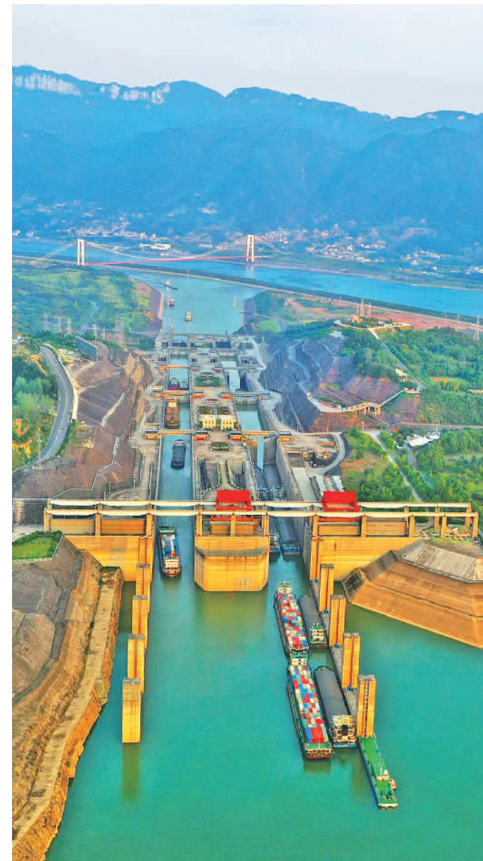
9月10日,船舶通过湖北省宜昌市三峡大坝双线五级船闸后在太平溪水域忙碌穿梭。今年前8个月,三峡双线五级船闸累计货运量达到1.02亿吨。这是三峡双线五级船闸首次在一年中的前8个月实现货运量突破1亿吨。黄善军摄(中经视觉)
