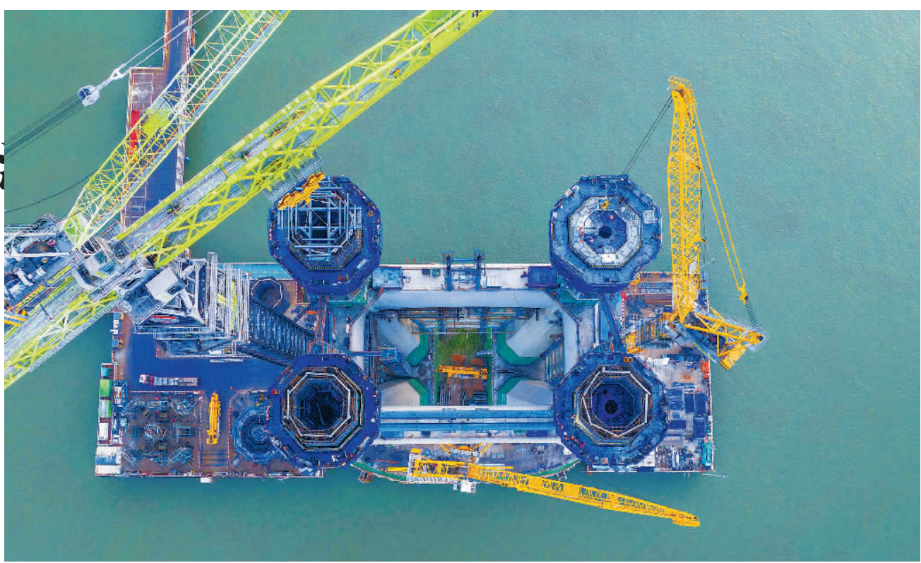
9月10日,工人在位于江苏省泰州市的常泰长江大桥建设项目工地施工。常泰长江大桥主航道桥主跨1176米,主塔设计总高352米。大桥建成后,对服务长江经济带建设和长三角一体化发展具有重大意义。 汤德宏摄(中经视觉)
