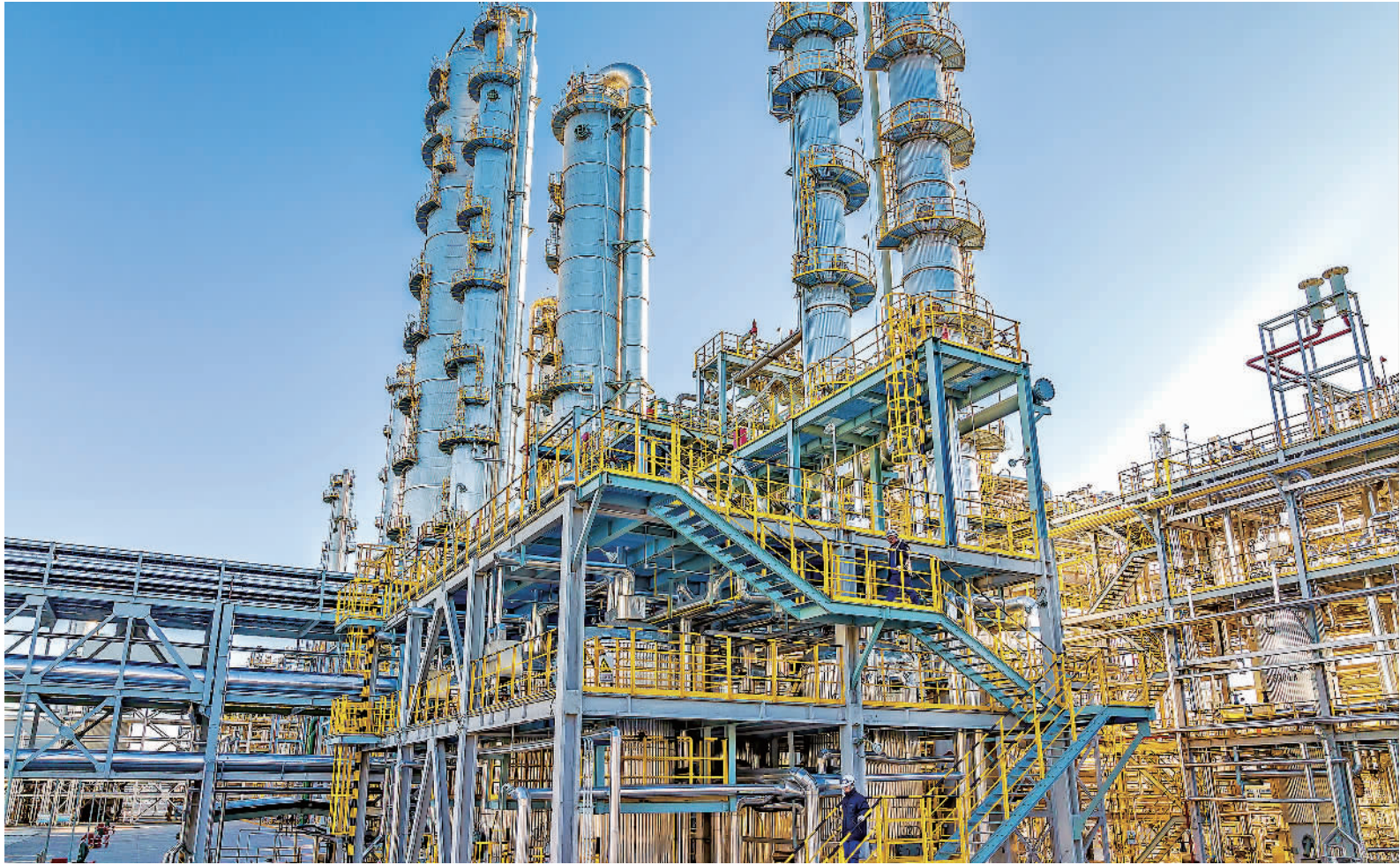
国家能源集团榆林化工有限公司乙二醇项目。
