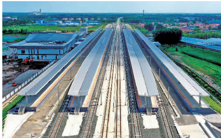
8月29日，俯瞰建设中的京唐城际铁路香河站站台及轨道，目前该站施工已进入收尾阶段。京唐城际铁路起自北京城市副中心站，终至河北省唐山站，线路全长约148.7公里，共设8座车站，根据不同路段设计时速为200公里至350公里，全线运行最短时间为30多分钟。沙飞摄（中经视觉）
