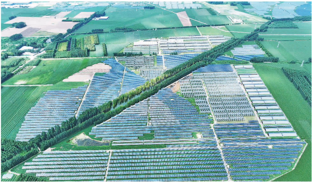
8月26日,晨曦中的山东济南南坝农光互补光伏电站。该电站是国内首座涵盖量响应、一次调频、快速调压三大主动快速支撑功能的新能源电站。近年来,济南加快推进乡村绿色低碳能源建设,持续做好技术支撑和并网服务,加快能源互联网建设,截至7月底全市新能源装机达357.66万千瓦,同比增长40.99%。刘荣磊摄(中经视觉)
