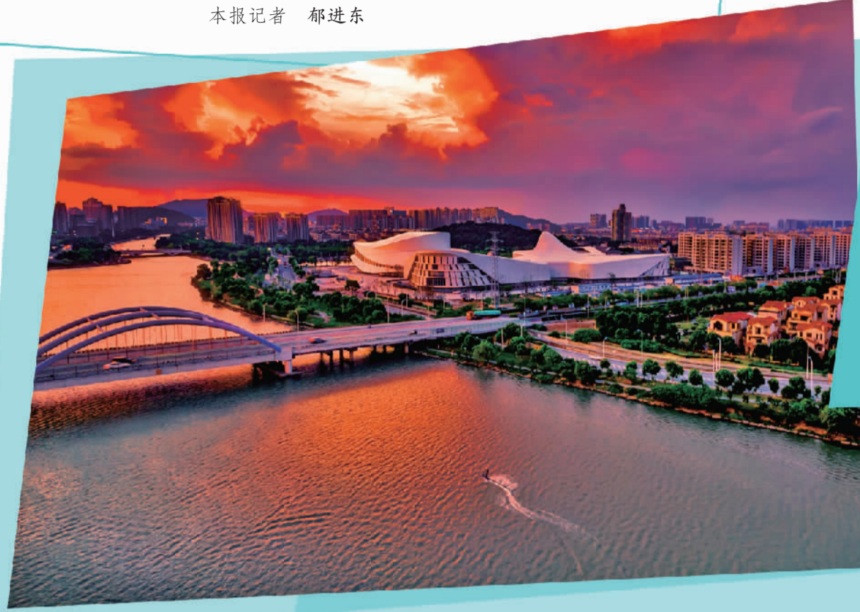
建设中的余姚市公共文化中心。
