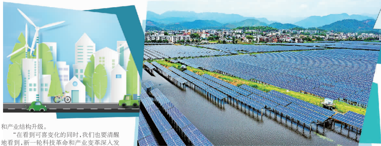
江西省赣州市上犹县营前镇30兆瓦渔光互补光伏发电项目采用上层光伏发电、下层水产养殖的新型模式,年均上网电量2900多万千瓦时。 朱海鹏摄(中经视觉)
