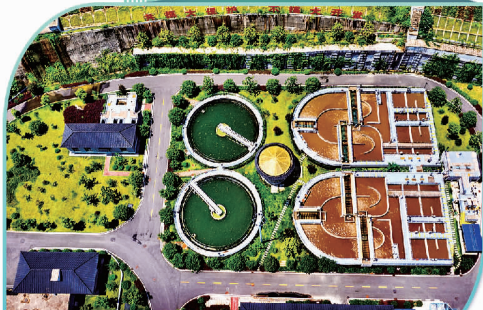
位于三峡大坝上游的湖北省宜昌市秭归县曲溪污水处理厂,其出水水质达到一级A国家最高排放标准。该项目的投运改善了秭归区域长江水体环境,对治理长江水污染、保护三峡水库水质和生态平衡产生了积极影响。 郑坤摄(中经视觉)
