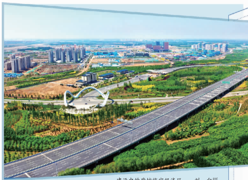
建设中的廊坊临空经济区。刘 向摄
