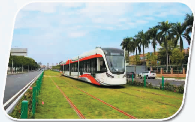
工行广东分行融资支持的广州黄埔区有轨电车1号线项目
