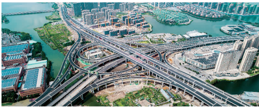
6月27日,杭州亚运会重点配套工程——浙江绍兴二环西路智慧快速路一期工程全线完工。该项目由绍兴市城投集团负责实施,中铁二十二局集团承建,将有效拉近杭州与绍兴亚运场馆间的时空距离。 侯钦佩摄 (中经视觉)
