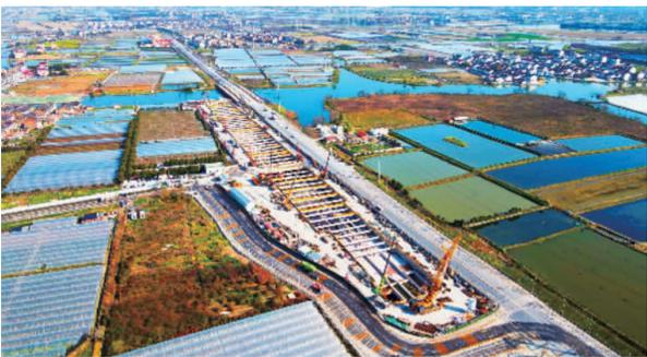
6月21日，随着最后一项顶板混凝土浇筑完成，中铁二十四局集团承建标段内的绍兴地铁2号线海南路站主体工程封顶，标志着全国首座软土层中具有停车检修功能的地铁车站主体结构基本完工。付林波摄（中经视觉）
