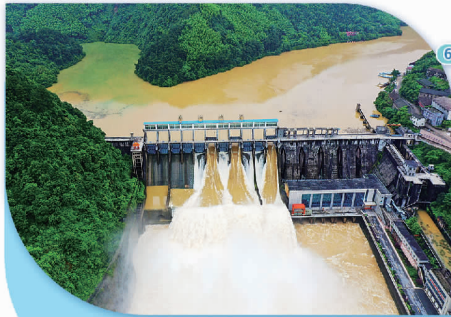
位于湖南省永州市的双牌水库开闸泄洪。日前,受强降雨影响,湖南省湘江上游潇水水位上涨,湖南水利部门及时科学调度水库泄洪,控制水库上下游水位,保障防汛度汛安全。何红福摄(中经视觉)
