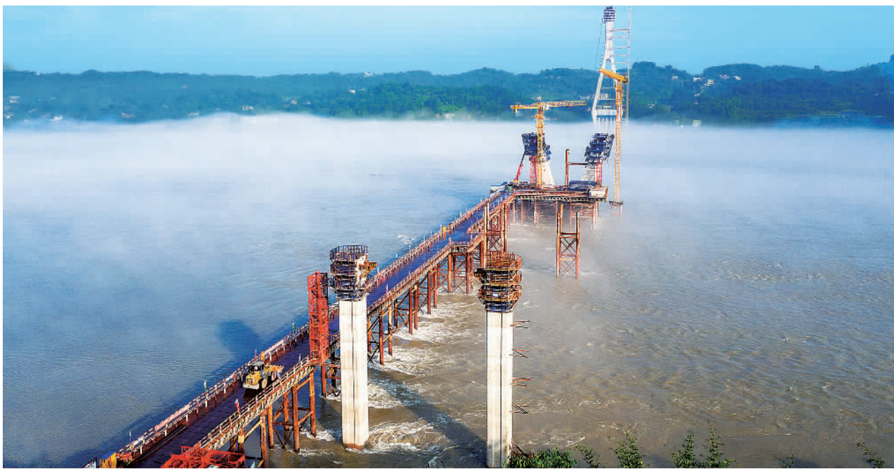
6月14日,工人在位于四川省泸州市合江县的榕山长江大桥项目现场施工。大桥总长超1500米,主桥为双塔、双索面、叠合梁斜拉桥,跨度530米,建成后有助泸州加快融入成渝地区双城经济圈。李贵平摄(中经视觉)
