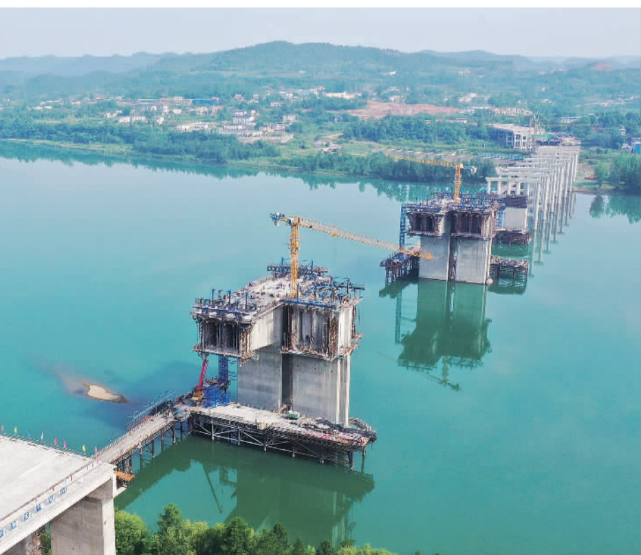
6月7日，四川省南充市蓬安县嘉陵江三桥施工现场。蓬安嘉陵江三桥规划全桥长为1239米，主桥为连续钢结构，桥梁分为左右幅，全桥桥宽38米，双向六车道，两侧设置2.5米人行道。嘉陵江三桥建成通车后，将进一步完善南充综合交通运输体系和高等级公路网布局，方便沿线居民出行，助力产业带打造以及物资运输。周亮摄(中经视觉)
