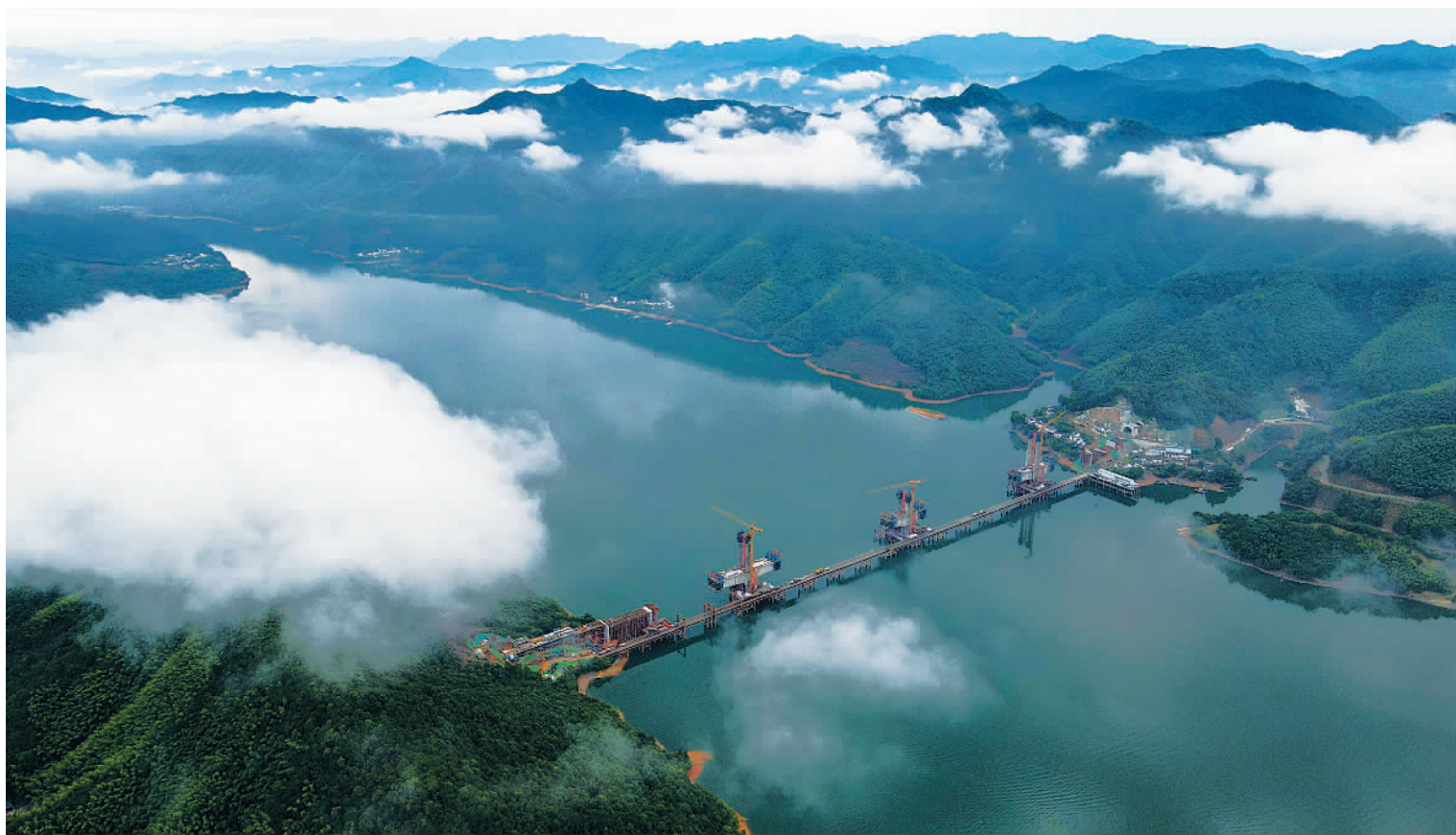
正在进行主塔封顶施工的池黄铁路太平湖特大桥(6月2日摄)。当日,由皖赣铁路安徽公司承建、中铁建大桥局施工的池(州)黄(山)铁路太平湖特大桥第一个主塔顺利封顶。
