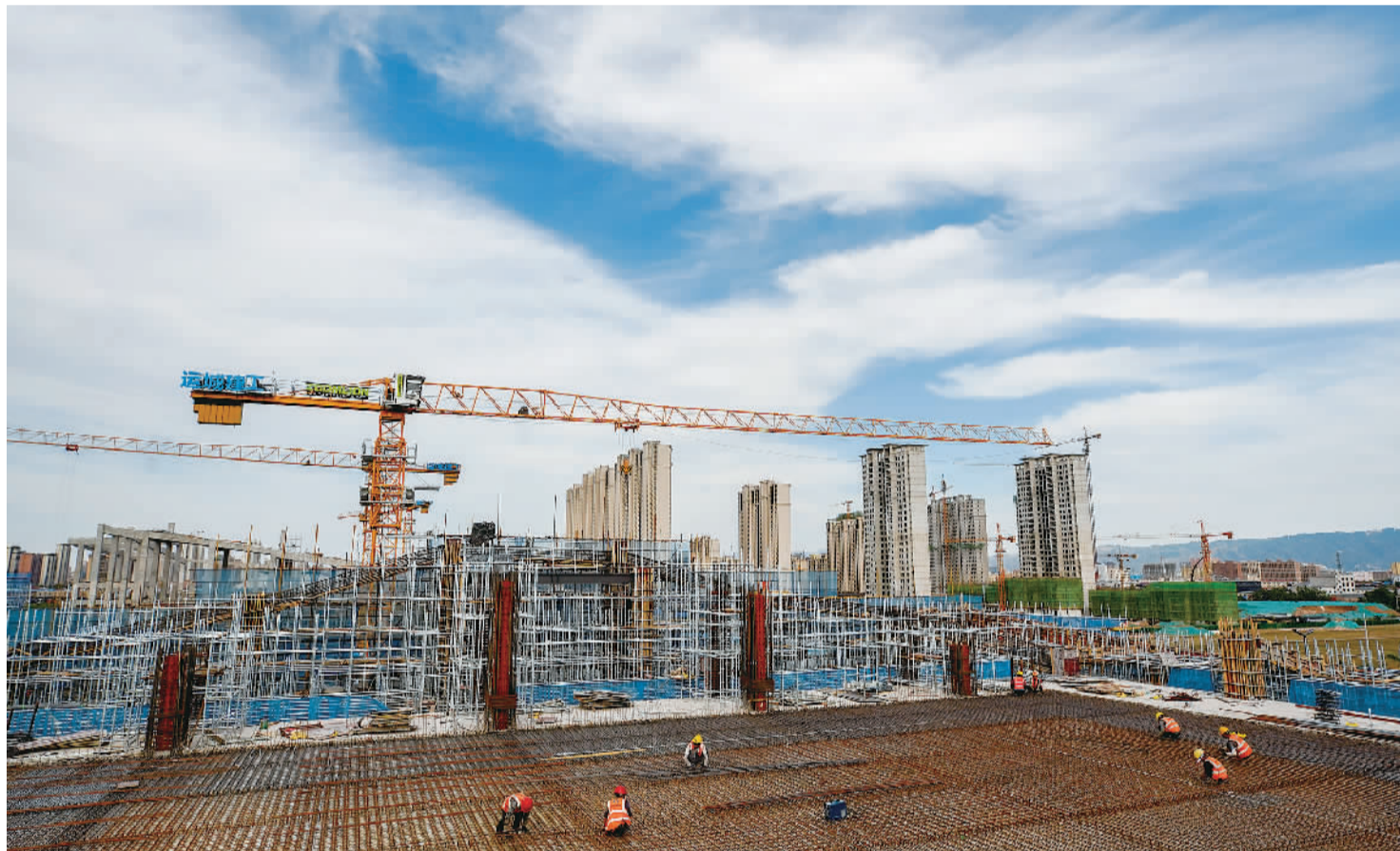
5月30日,山西省运城城市,工人正在运城城市会展中心重点工程工地上实施钢筋焊接和管线对接作业。该项目总投资8.54亿元,占地8.2万平方米,预计今年年底完工。建成后除了满足各类大型展会需求外,对拓展城市发展空间、提升城市品位具有一定积极作用。 闫鑫摄(中经视觉)
