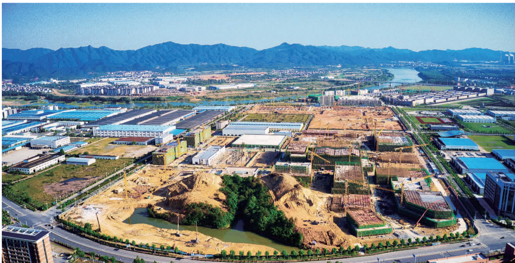
5月19日，江西景德镇高新区通用航空产教融合基地项目建设现场，施工正在加紧进行。今年以来，景德镇高新区聚焦航空、新能源、新材料“一航两新”主导产业，高标准建设68万平方米数字经济产业园，大力引进高端数字经济企业。 罗 斌摄(中经视觉)
