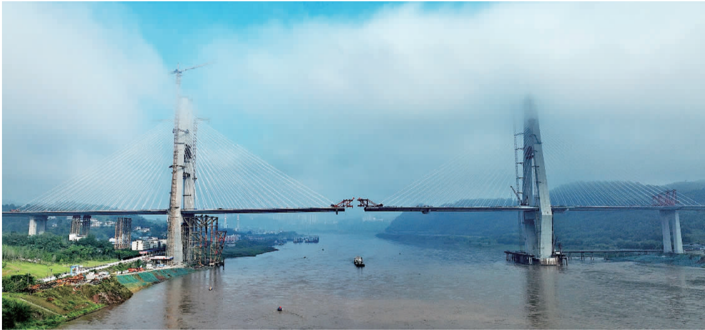
5月10日，正在建设的宜宾临港高铁两用长江大桥即将合龙。该桥横跨四川省宜宾市叙州区和三江新区，全长1742.1米，大桥主跨522米，主桥标准梁宽63.9米，是国内最宽的公铁两用桥和跨度最大的公铁平层斜拉桥。兰锋摄（中经视觉）
