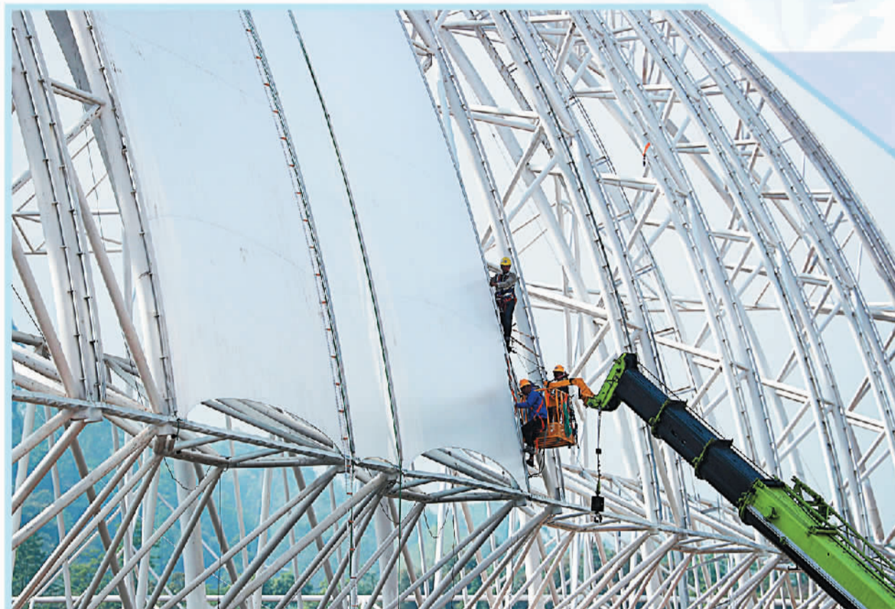
四川省华蓥市物流园区高兴货场,是目前川东渝北地区在建的发货量最大的货场,涉及冷链储运、煤炭、建材、石油等行业。
