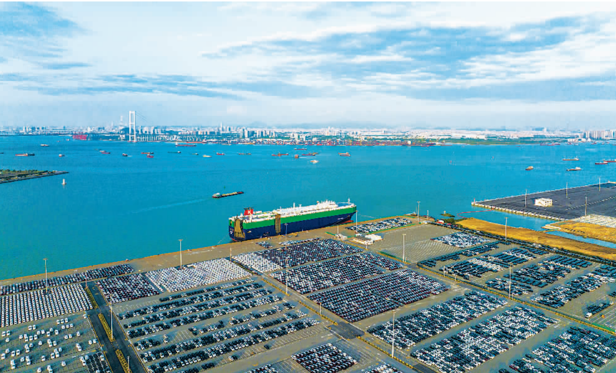
4月22日，广州港南沙汽车码头车辆井然有序，吞吐繁忙。一季度，广州港累计完成商品汽车装卸40.7万辆，同比增长5.7%，其中外贸出口3.7万辆，同比增长超过70%。目前，经广州港出口的主要汽车品牌达10余个，航线网络覆盖中东、东南亚、北美、欧洲、非洲等地区。
