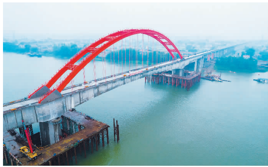
4月15日，国家重点工程常(德)益(阳)长(沙)高铁控制性工程资水特大桥施工，为常益长高铁早日通车运营奠定坚实基础。据悉，常益长高铁建成后，将实现湖南全省14个市州全部通高铁，长沙至常德预计只需半小时。 谢永彬摄(中经视觉)
