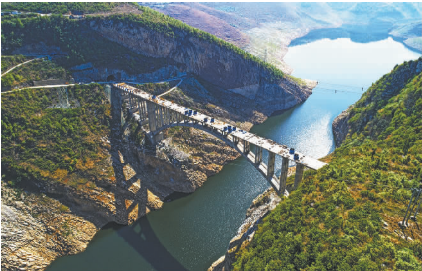
近日,贵州省毕节市白甫河倒虹管跨河拱桥主体工程完工。白甫河拱桥是贵州省重点工程夹岩水利枢纽工程的重要组成部分。该工程以城乡供水和灌溉为主,兼顾发电,将为区域开发和改善生态环境提供助力。 史开心摄(中经视觉)
