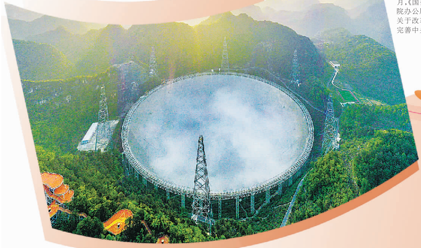
被誉为“中国天眼”的500米口径球面射电望远镜全景。依托“中国天眼”在射电低频波段领先的观测能力,我国天文学家在脉冲星搜寻能力和效率上,已大幅领先国外脉冲星搜寻团队。
