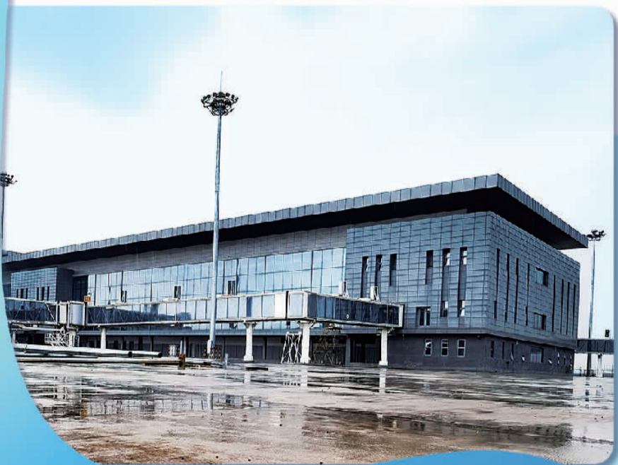
上图 尼日利亚拉各斯国际机场新航站楼项目外景。
