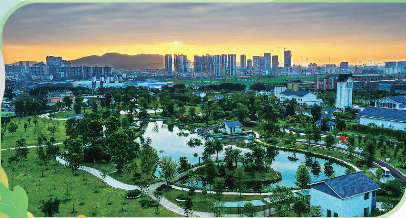
图为广州石井净水厂。广州中心城区目前共建设和升级9座生态化地埋式净水厂,总日处理能力达181万吨。新华社记者 刘大伟摄
