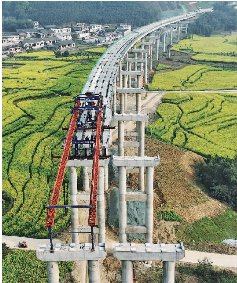
3月13日,四川省宜宾市长宁县双河镇的宜威高速2标桥头大桥进行T梁架设作业。宜威高速全长106.4公里,建成通车后将强化四川与滇中及东盟的联系具有重要意义。 兰锋摄 (中经视觉)
