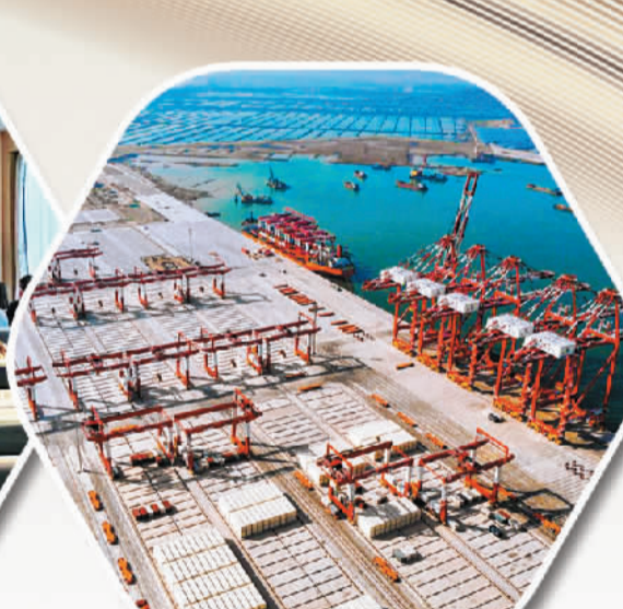
进出口银行广东省分行支持的广州港南沙四期工程
