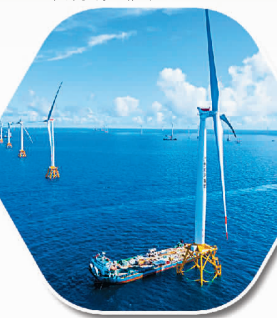
进出口银行广东省分行支持的某海上风力发电项目
