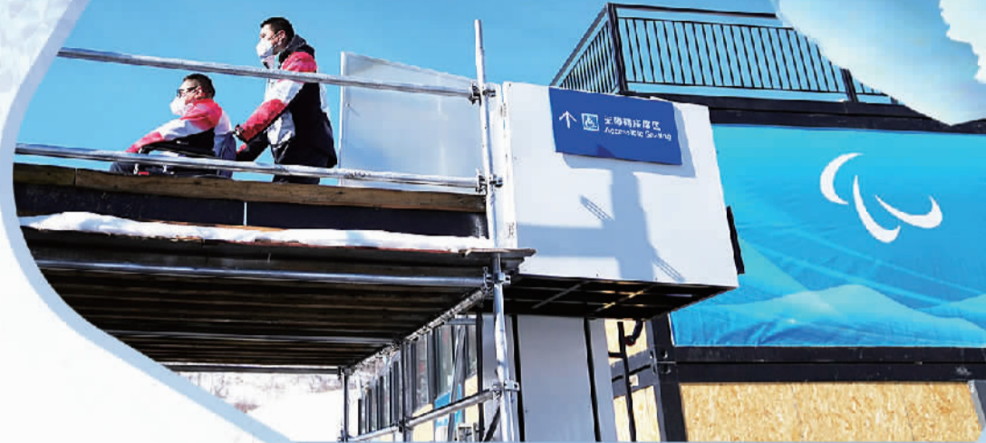
上图 张家口赛区场馆内的无障碍设施。
