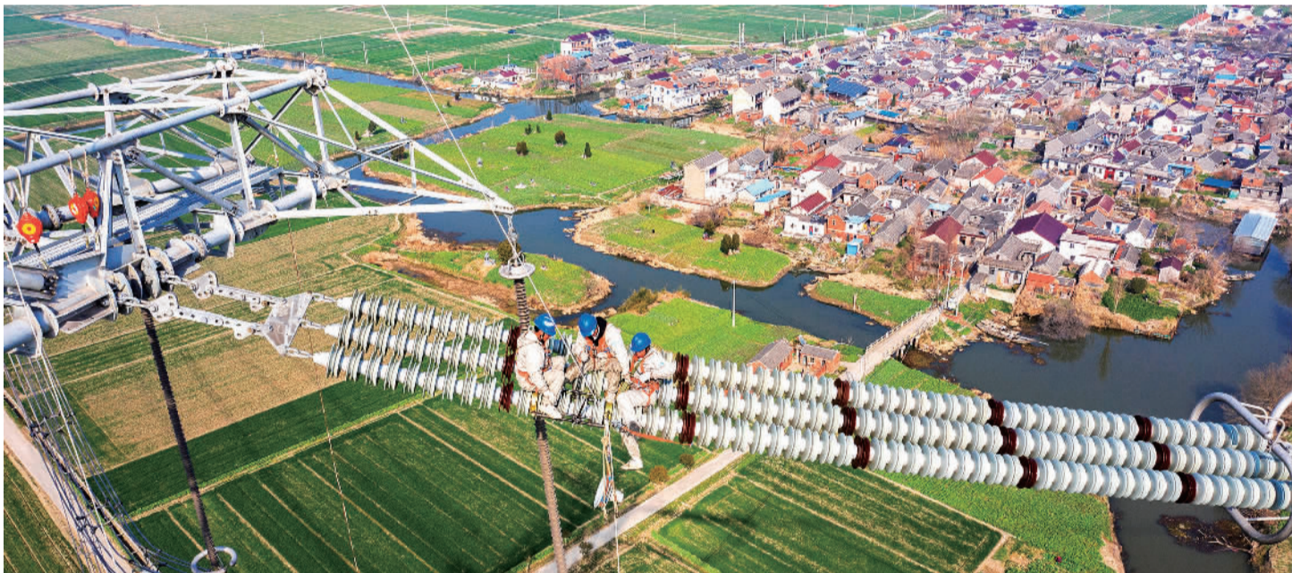
3月2日,江苏省泰州市1000千伏秦吴线I线检修现场,检修人员在百米高空对线路展开“体检”,保障特高压电网安全稳定运行。 史俊摄(中经视觉)
