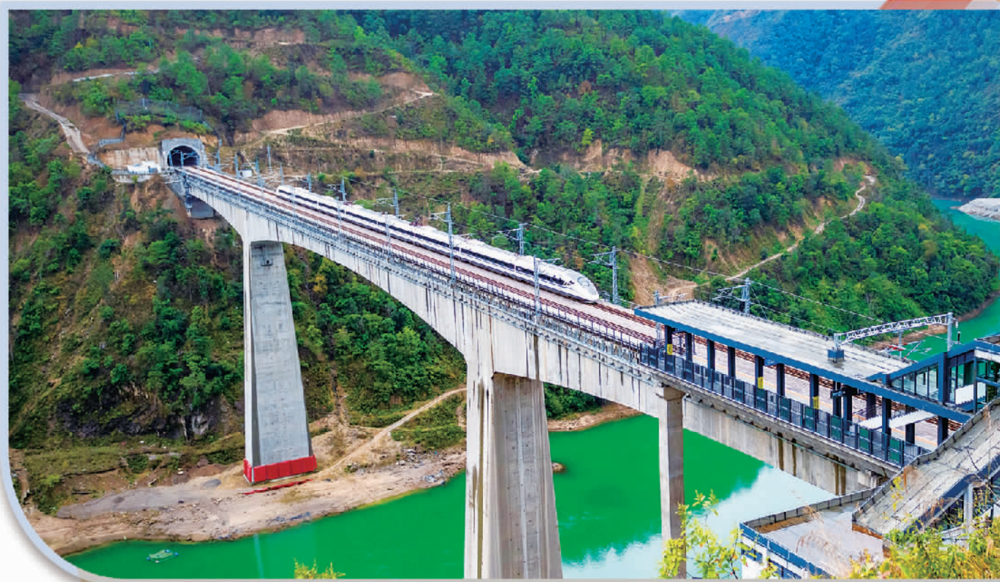
2021年11月6日，云南大（理）临（沧）铁路小湾东站开通，周边数十万群众的生产、生活受益。图为—列车组列车经过小湾东站。新华社记者 陈欣波摄
