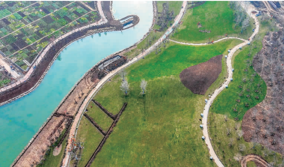
2月20日，湖北省襄阳市襄水景区正在进行绿化等收尾工作。该工程在保留原有土丘密林地貌的基础上，对堤岸进行拓宽，修筑拦水坝，打造出生态塘风光貌。同时，新建了生态停车场、生态厕所、襄源驿站等服务设施，为游客提供便利。杨 东摄（中经视觉）
