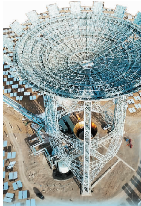
甘肃玉门鑫能50兆瓦熔盐塔式光热电站。 新华社记者 范培坤摄
