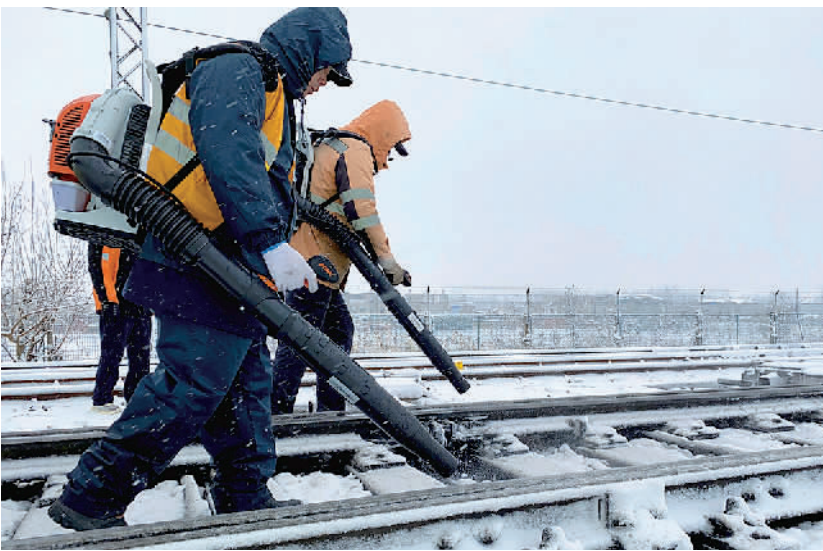
2月7日，安徽蚌埠突降中到大雪，上铁蚌埠站干部职工立即行动，清扫线路上的积雪，进行除冰作业，确保京沪干线安全畅通。
