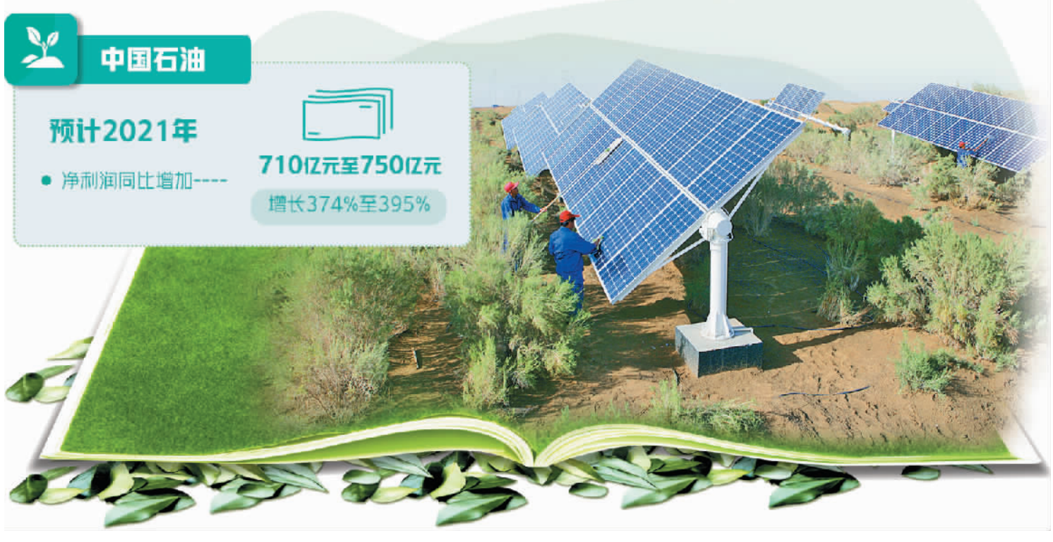
玉门油田200兆瓦光伏并网发电示范项目的技术人员正在连接光伏发电板线路。(资料图片)
