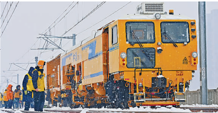
1月23日，中国铁路郑州局集团有限公司干部职工对郑开城际铁路运粮河站开展道岔捣固及整修作业，提升线路、道床及道岔质量状态，为春运期间铁路运行夯实设备基础。王 玮摄(中经视觉)
