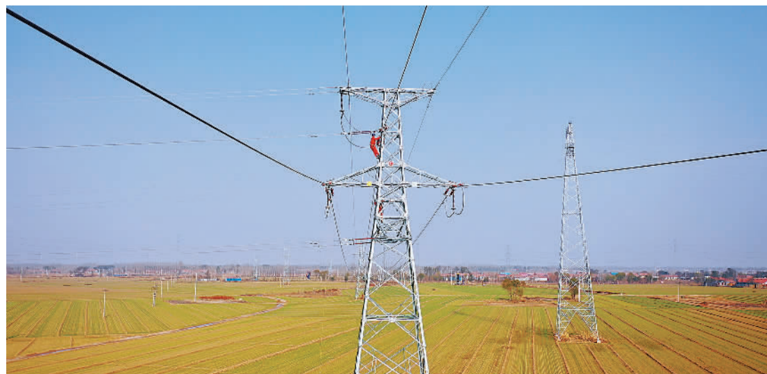
1月21日,国网施工人员在山东德州临邑县110千伏邢韩线进行铁塔T接线工作。当地加快推进重点输电工程建设,保障生产生活用电,助力经济发展。 杜瑞瑞摄(中经视觉)
