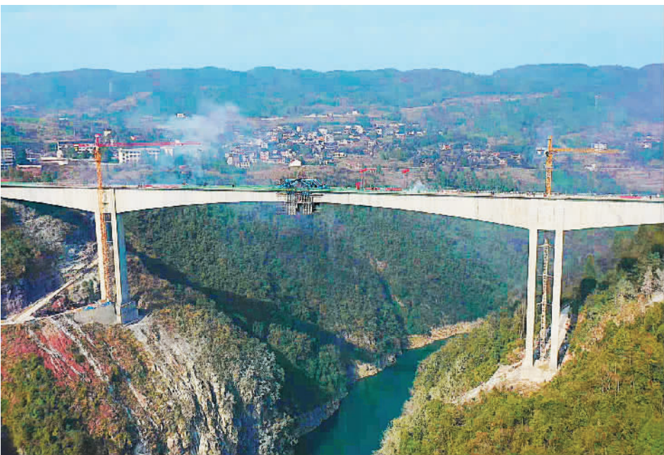
1月17日，湖南省永顺县泽芙公路列乡特大桥顺利合龙。该大桥全长462米，主跨235米，预计今年6月底竣工通车。王承良摄（中经视觉）
