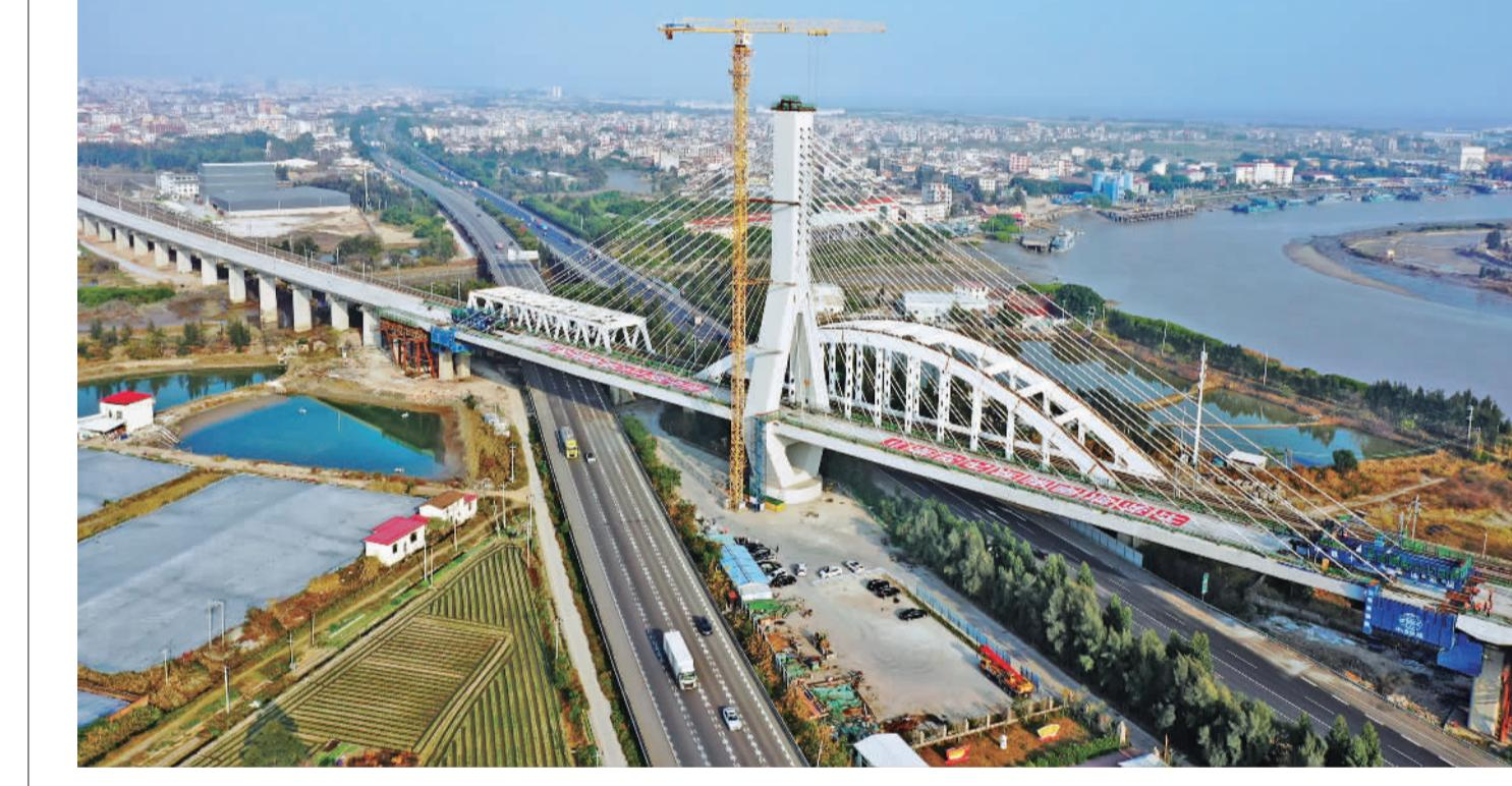
1月16日,由中铁十六局集团承建的新建福厦铁路木兰溪特大桥斜拉桥主梁顺利合龙。该桥位于福建省莆田市木兰溪河畔,全长18746.92米,是全线重点控制性工程之一。
