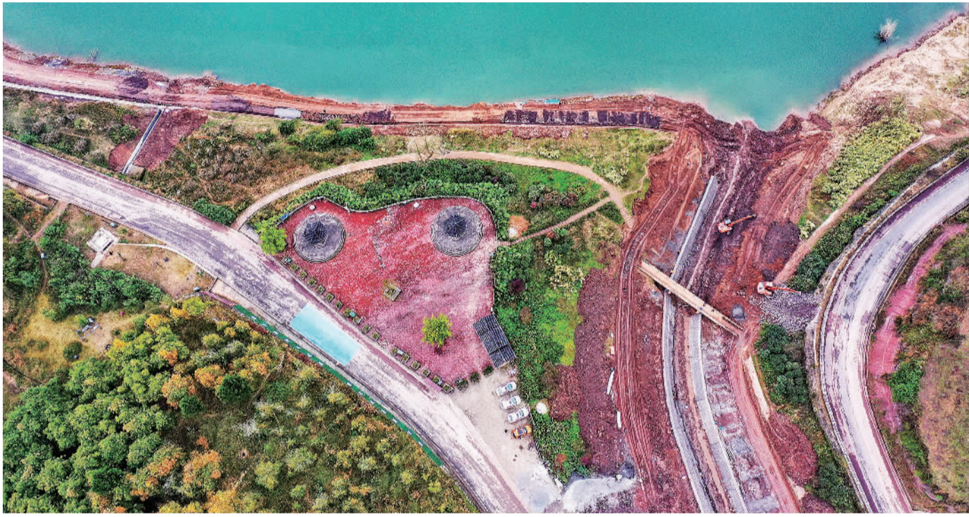
1月8日，四川省华蓥市明月镇，工程机械正在河道施工。当地积极利用冬闲和枯水时节，加紧对境内的渠江及其支流实施河堤、保坎修筑和淤泥、积沙清除工程，不断提升两岸生态环境。
