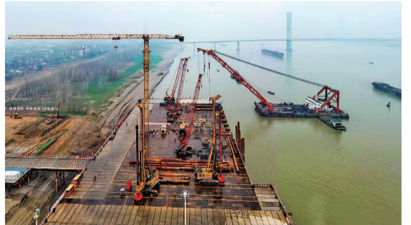
1月4日,安徽省铜陵市G3铜陵长江公铁大桥正式动工兴建。该大桥全长11.88公里,为双层斜拉—悬索协作体系大桥,其建设对促进区域交通优化发展、推动长三角一体化发展等均有重要意义。高凌君摄(中经视觉)
