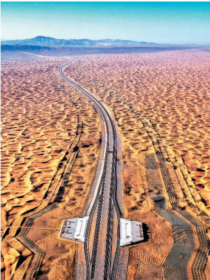
12月29日拍摄的乌玛高速青铜峡至中卫段穿越腾格里沙漠路段。当日,乌玛(内蒙古乌海市至青海玛沁县)高速青铜峡至中卫段正式通车。该路段全长122.99公里,其中18公里穿越腾格里沙漠腹地,是宁夏建设的首条沙漠高速公路。 新华社记者 冯开华摄
