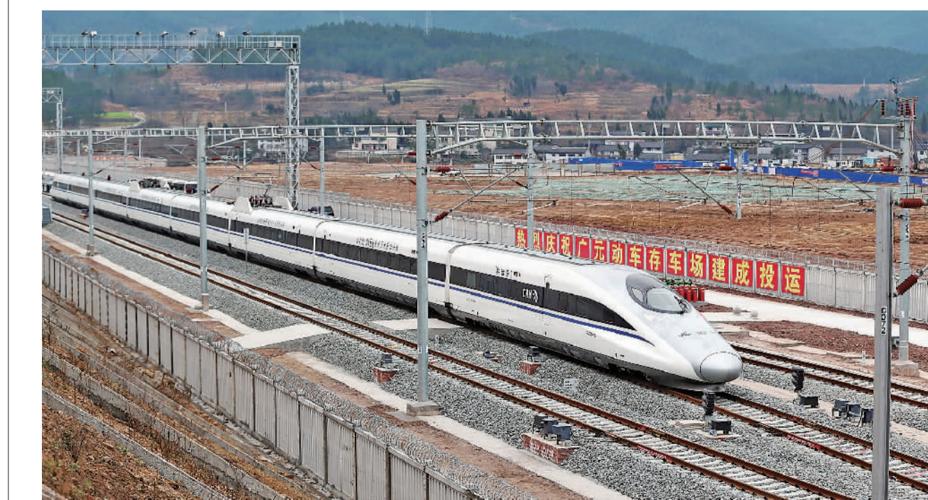
12月26日,位于四川省广元经济技术开发区盘龙镇东升村的广元动车存车场竣工投运。广元动车存车场线路接轨兰渝、西成联络线,建成的3条存车线可满足6列短编动车组同时停放。建成后将进一步完善广元铁路枢纽功能,优化广元始发至成都、贵阳、广州等方向动车运营时刻、开行班次,有利于广元更好地融入成渝地区双城经济圈建设。唐 彪摄(中经视觉)
