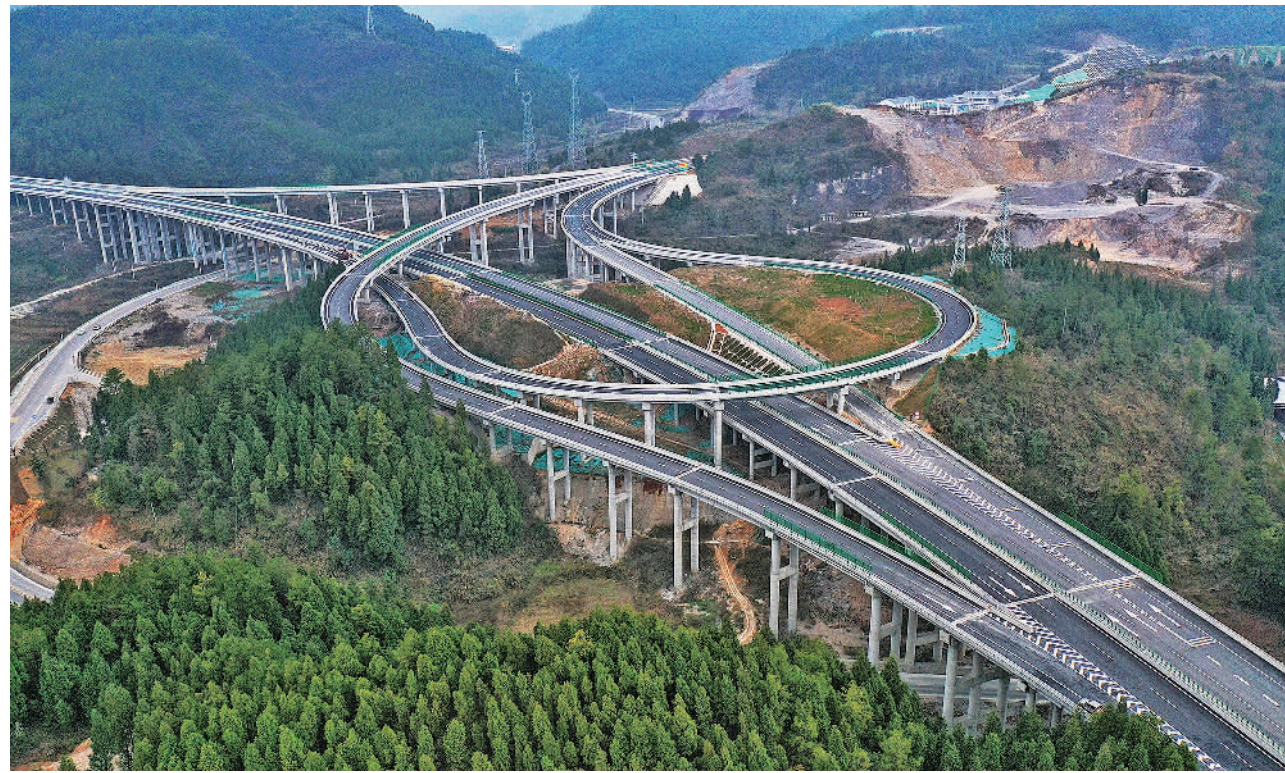
12月25日，俯瞰贵州省江(口)玉(屏)高速公路黄牯山枢纽。连日来，工作人员加紧施工，为12月31日正式开通运行作准备。该公路是贵州省高速公路网重要加密线，全长73.63公里，全线有桥梁53座，隧道15座。胡攀学摄(中经视觉)
