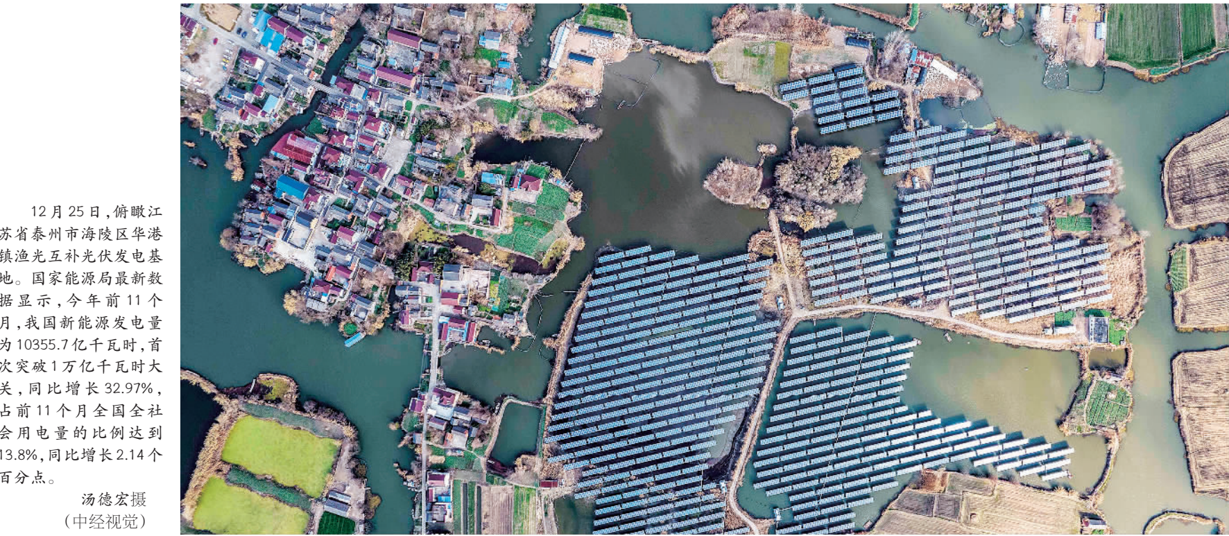
12月25日，俯瞰江苏省泰州市海陵区华港镇渔光互补光伏发电基地。国家能源局最新数据显示，今年前11个月，我国新能源发电量为10355.7亿千瓦时，首次突破1万亿千瓦时大关，同比增长32.97%，占前11个月全国全社会用电量的比例达到13.8%，同比增长2.14个百分点。
