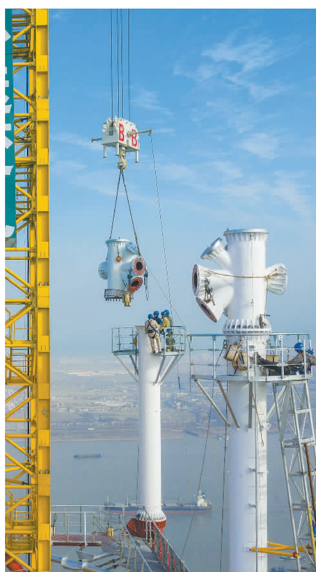
12月21日,在世界最高输电铁塔500千伏凤城至梅里长江大跨越施工现场,江苏省送变电有限公司施工人员正在340米高空安装铸钢铜管节点,保证工程按计划推进。
