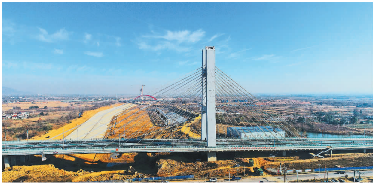
12月19日,工程建设者在安徽省庐江县周瑜大道桥进行斜拉索精调作业。周瑜大道桥是庐江县境内“引江济淮”关键性施工节点项目。目前,该桥梁主体及连接线路面工程已全部完工,正抓紧为通车运营做最后准备。王 闯摄(中经视觉)
